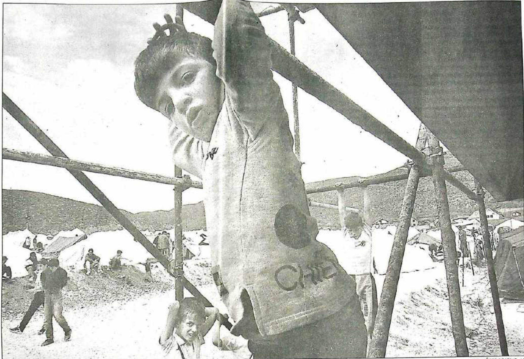
Vluchtelingenkinderen spelen bij een toiletgebouw in aanbouw in het opvangkamp in Bojane, Macedonië.
